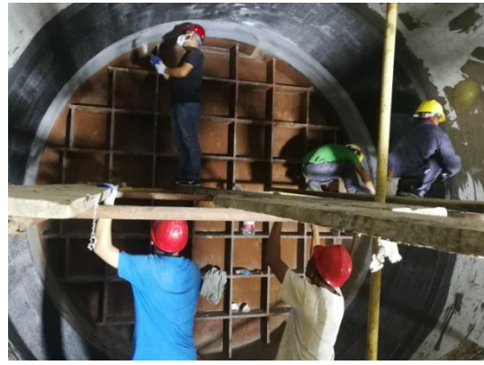
图 3 垫层表面粘贴环向碳纤维施工现场
