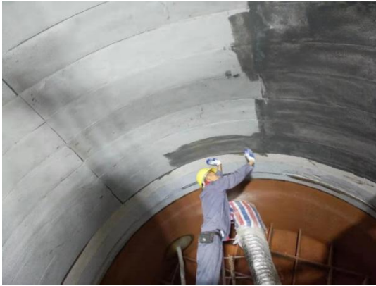
图 2 高压缩弹性垫层表面刮涂腻子找平
