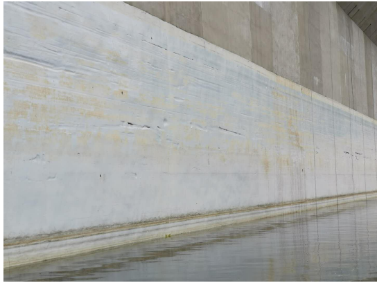
照片 9 SK 天冬聚脲防冰拔复合防护体系运行一年效果
