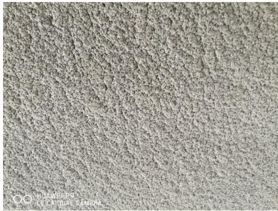
照片 1 未打磨前保温层表面
