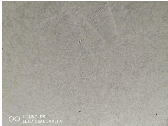
照片 2 刨平机打磨后保温层表面情况
