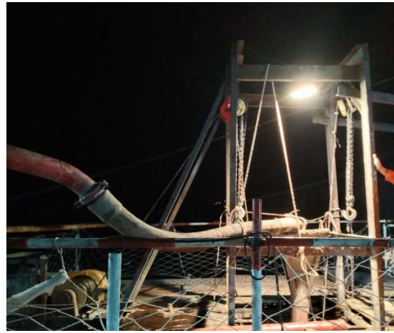
图 3 布料机和浇筑导管对接处
