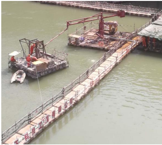
图 2 布料机浇筑示意图
