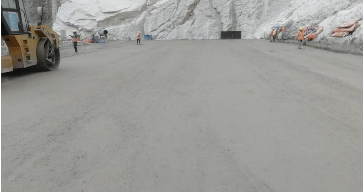
图 4 施工现场碾压仓面收面效果
