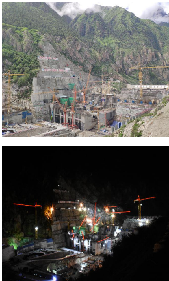
图 1 施工现场起重设备布置情况（昼/夜）
