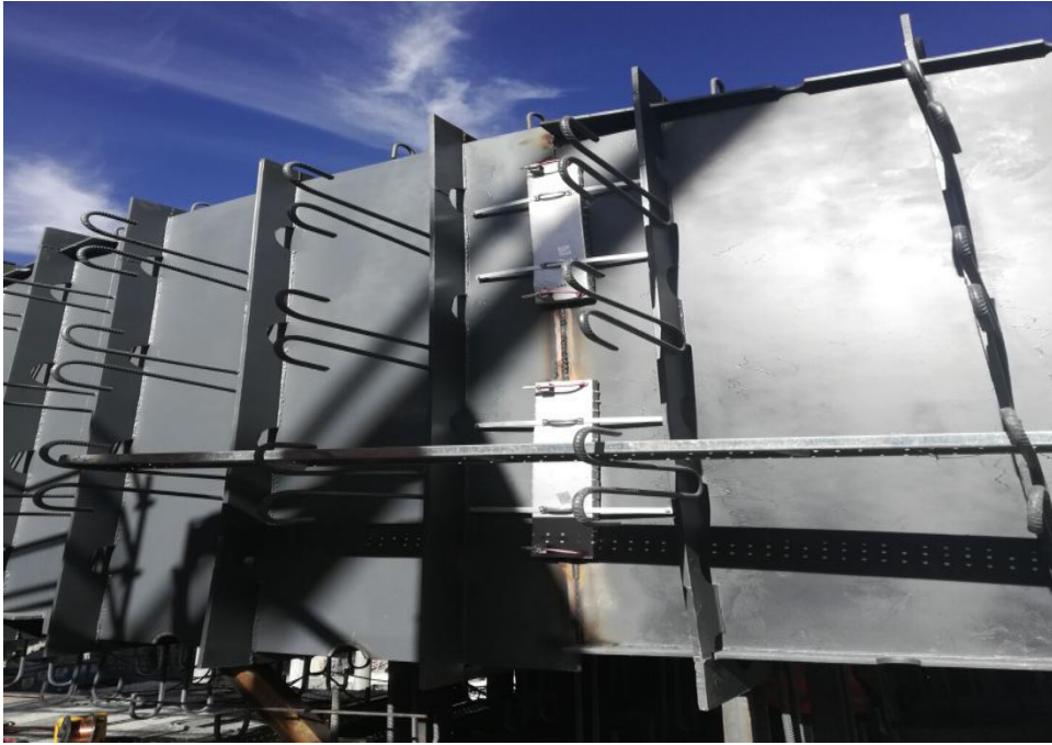
图2 加温板进行焊前预热
