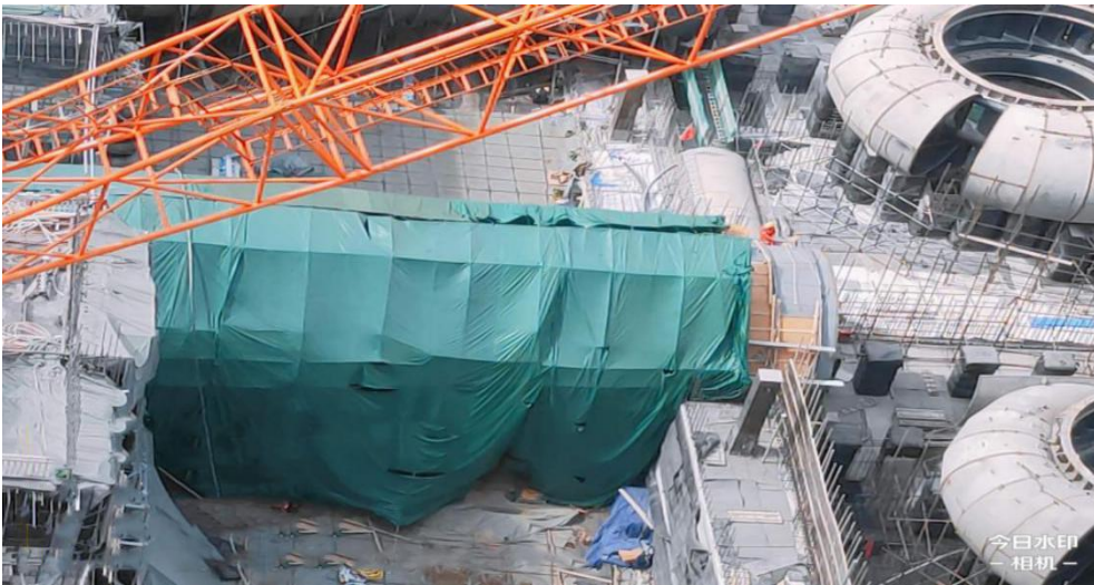
图1 焊接时搭设的保温棚
