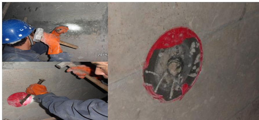
图 8 预埋管现场敲击寻找照片
