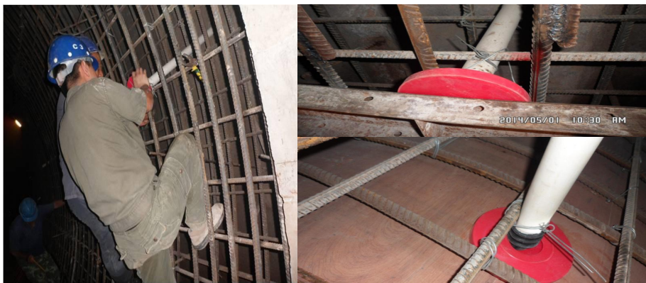
图6 雀巢聚音式灌浆预埋管现场安装照片
