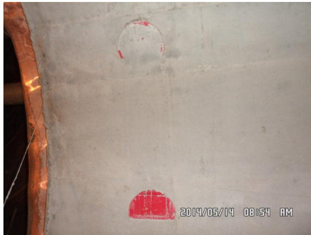
图 7 拆模后预埋管照片
