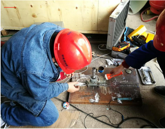
图 4 钻孔装置安装
