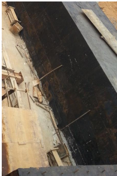
图3 箱涵润滑隔离层设置示意图
