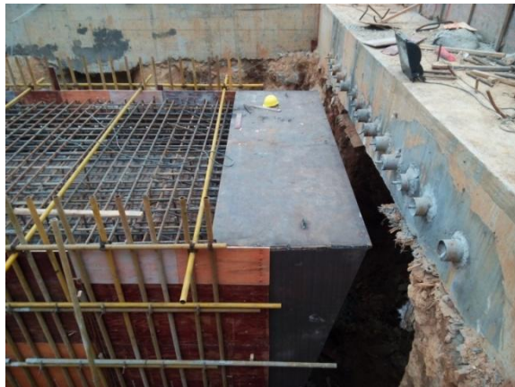
图 1 崩冲顶进箱涵管棚示意图
