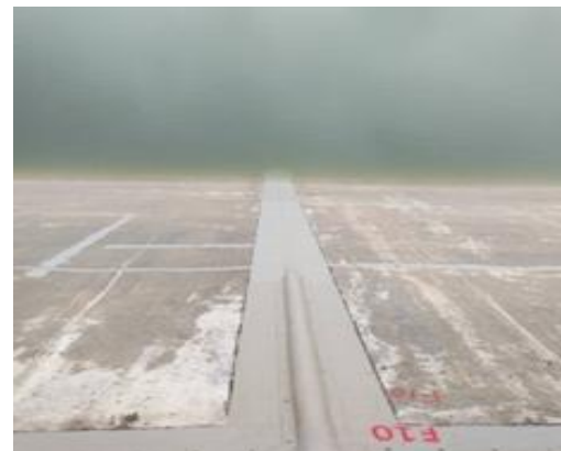
图5 纳子峡面板接缝止水修复
