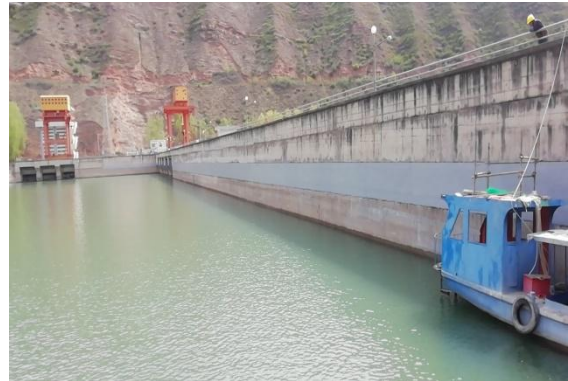
图11 海甸峡混凝土坝冻融剥蚀处理后情况
