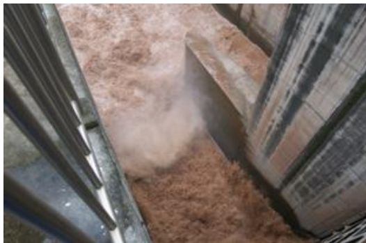
图 16 柳洪水电站泄水闸 2016 年汛期泄水
