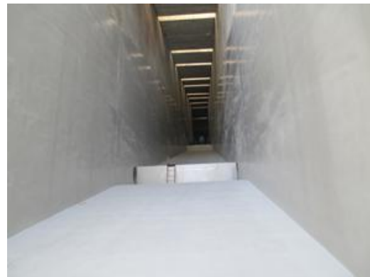
图 13 李家峡溢洪道抗冲磨防护
