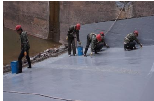
图 15 柳洪水电站泄水闸底板修复
