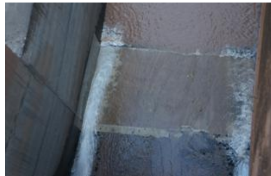
图 17 泄洪后闸室底板完好
